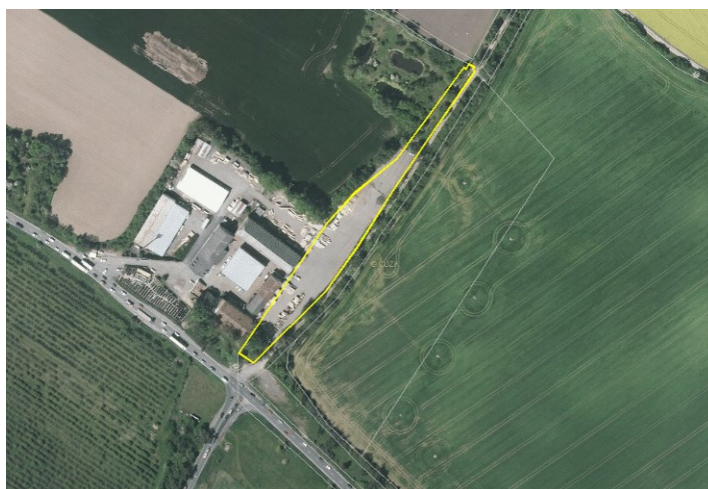
Část areálu, který zashuje do řešeného území ze sousedního správního území – Libenice. Hranice zástavěného území je vedená po parcelních hranicích.
